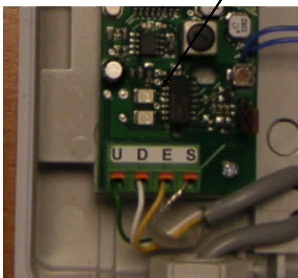
Bild 5: Teilausschnitt abgesetzte Antenne
