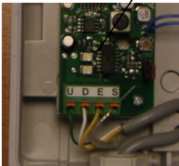
Bild 5: Teilausschnitt abgesetzte Antenne
